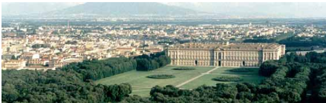
> Vue aérienne du palais royal de Caserte
