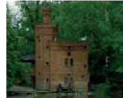
> Le bâtiment des pompes à eau
