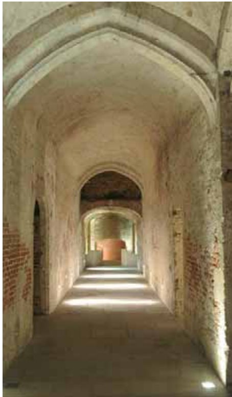
> Sous-sol de la chapelle © M. Vanhulst
