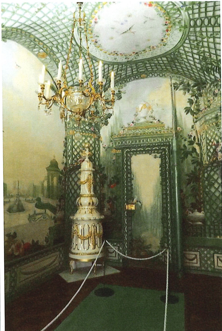
Schloß Schönbrunn, Räume im Erdgeschoß, sogenannte Bergzimmer. Die Sprenkleranlage nimmt hier die Dekoration des Raumes auf. Rechts neben der Tür steht ein grünes Rohr mit dem Sprühkopf der Sprenkleranlage.
