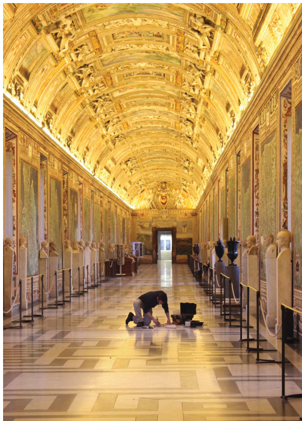
Fig. 5 Marble floor repair inside the Gallery of Maps. (© Governatorato SCV – Direzione dei Musei)
