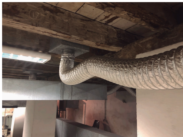
Fig. 6 Installation du système de traitement climatique en sous-sol. (© Fundação Casa de Rui Barbosa / Claudia Carvalho)
